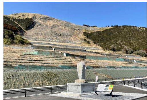
大規模斜面崩落
