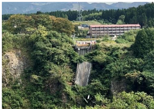
崩落した旧阿蘇大橋の橋桁
